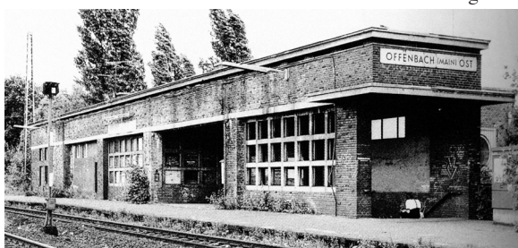
Offenbach Ost: Nach neuesten Erkenntnissen der Behörden handelt es sich bei diesem Bahnhof ebenfalls um ein „Kulturdenkmal“; abgerissen zu Beginn der 90er Jahre des letzten Jahrhunderts; seit 2005 in die Denkmaltopografie des Landes Hessen aufgenommen. Quelle: Landesamt für Denkmalpflege Hessen
